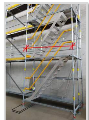
Abb. 4.7-36: Baugerüst mit zeichnerischen Ergänzungen
